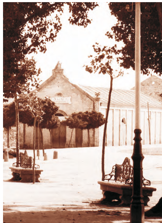
Detalle da fachada norte do “Salón Variedades”. 1910-1920
